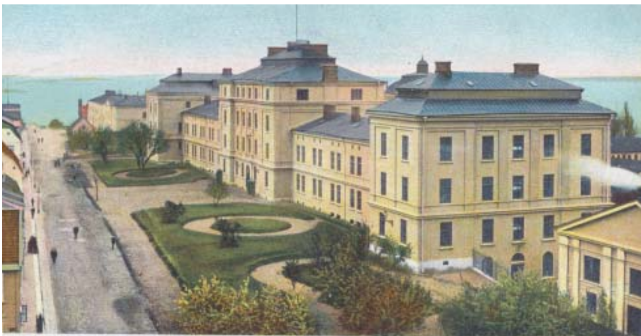
Nuvarande kasern Najaden (Norra kasern) någon gång åren 1895 – 1902. Längst till höger skimtar Gamla tyghuset, som revs 1902 för att ge plats åt Södra kasern (Jarramas). Längst bort på Vallgatan synd ett litet hus nästan mitt i gatan. Detta var Amiralitetskyrkans vaktmästares bostad.
