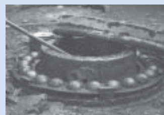
Kullagret under lavetten. Tre av kulorna finns i dag på Museet Aspö
